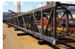
Combo tower per il parco Ferrari World (Spagna) attualmente in costruzione
